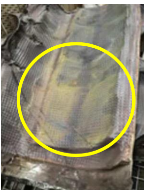
Chromrückstände auf der Isolierung
